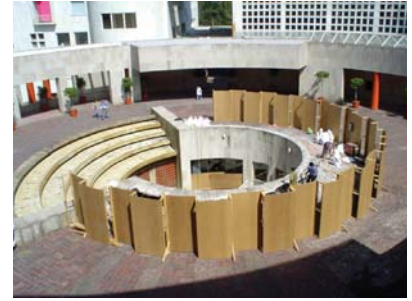
Construcción del Domo
