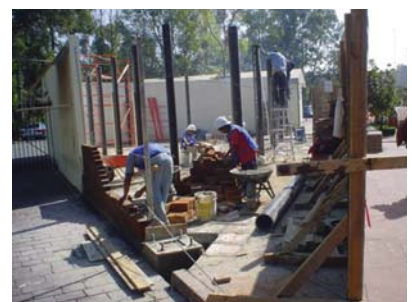
Construcción de la Sala de Espera
