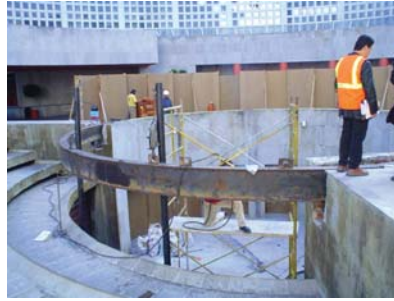
Inicio Construcción del Domo
