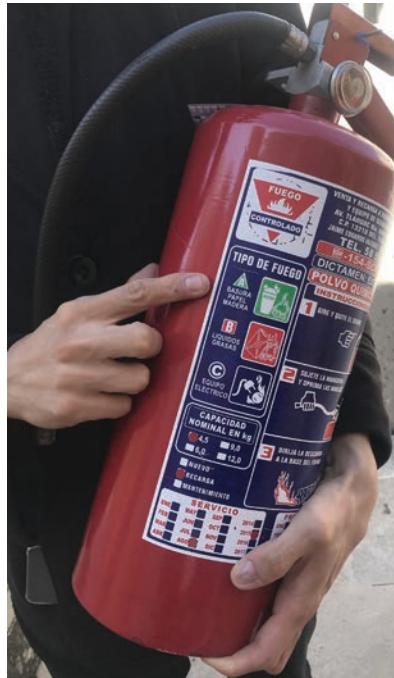
Identificar el tipo de extintor que se va a utilizar.
